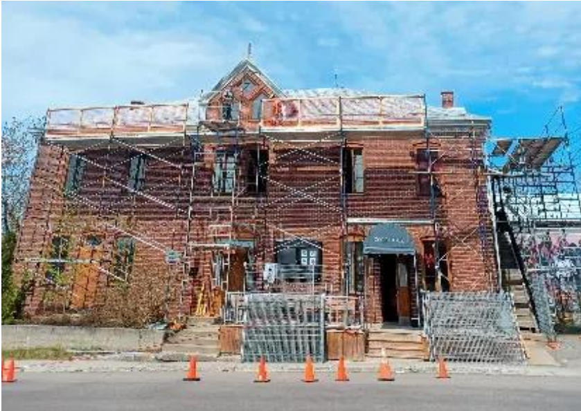
Depuis quelques jours, telle est l'apparence épousée par le Côté-Cour de Jonquière, en raison des travaux menés sur la toiture. Ils n'empêchent cependant pas la tenue des spectacles, puisque ceux-ci ont lieu quand le chantier est fermé.
